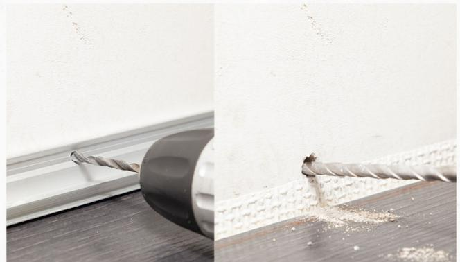
3. Schrauben Sie die Schienen an die Wand. Achten Sie darauf, dass alle Schrauben richtig versenkt sind.
